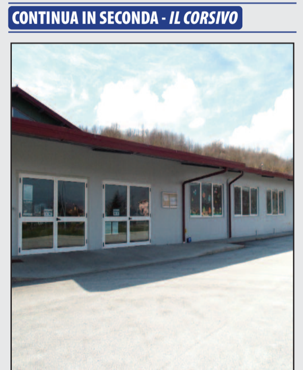
UN PREFABBRICATO SCOLASTICO ALL'AQUILA
