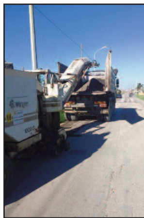
LAVORI IN CORSO DI VIA DEI PLATANI
