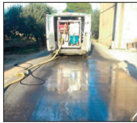
che hanno bloccato la strada dalle 14.30 in poi - e la ditta di pronto intervento per il ripristino del manto stradale.
