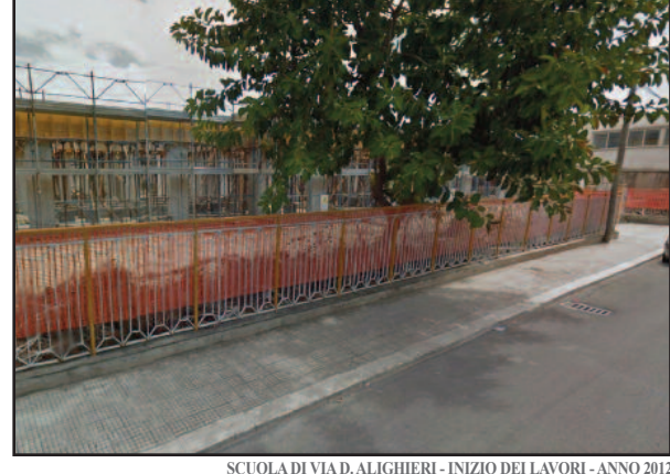
SCUOLA DI VIA D. ALIGHIERI - INIZIO DEI LAVORI - ANNO 2012
