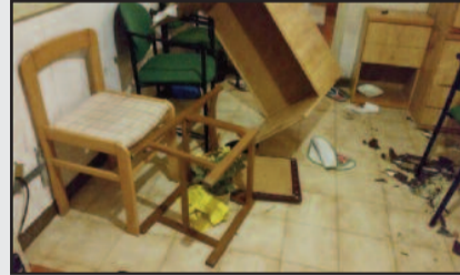
IL DANNO CAUSATO ALLA STRUTTURA
