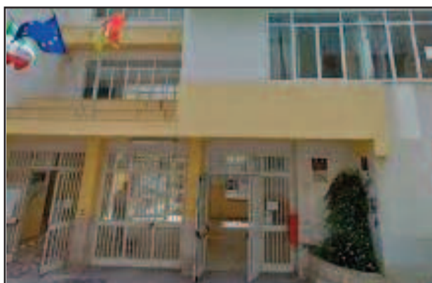
IL PLESSO CAVOUR
