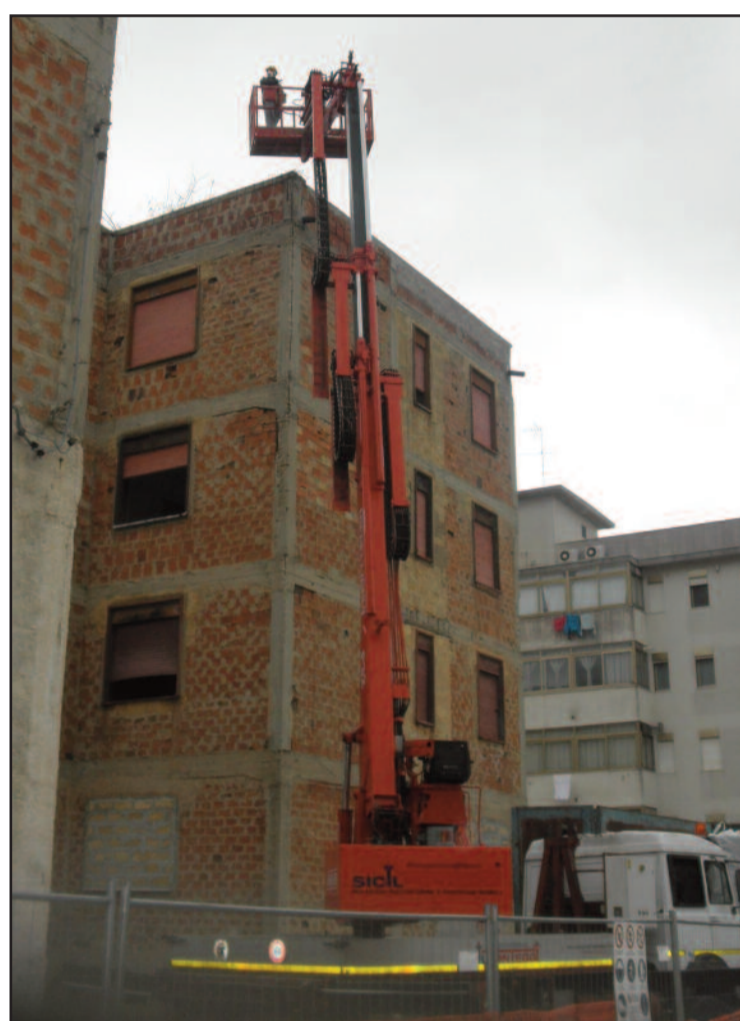
ALCUNI MOMENTI DELLE DEMOLIZIONI
