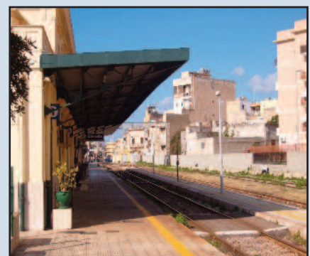
STAZIONE FERROVIARIA DI MARSALA
