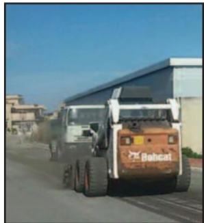
LAVORI IN VIA GIANINEA
