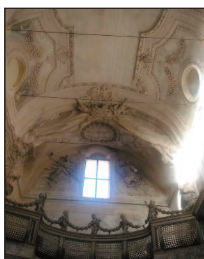
NELLE FOTO LA CHIESA SANTO STEFANO DOPO IL SOPRALLUOGO DEL 2017
