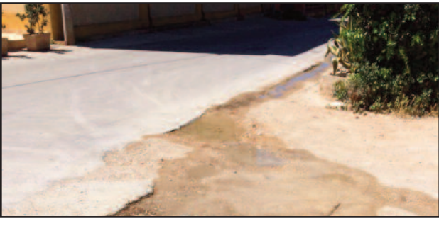
LA FUORIUSCITA DI ACQUA LUNGO LE STRADE
